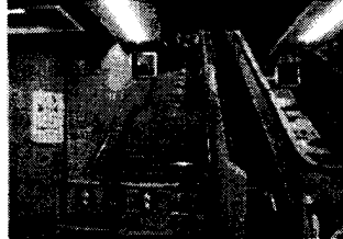
灣仔站最近竣工的扶手電梯及樓梯新貌
