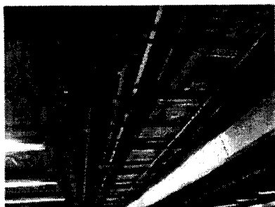
已拆除彩虹站月台的假天花，以便進行月台幕門的結構支承安裝工程
