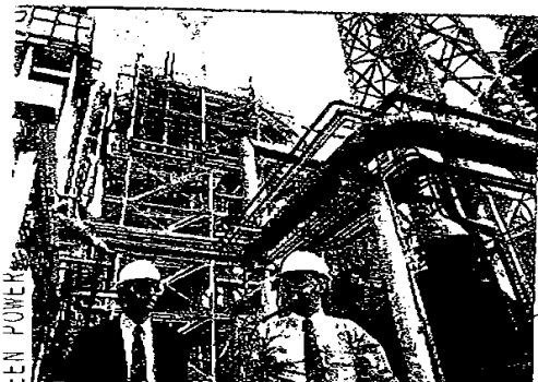
青衣化學廢物處理廠在技術、運作、焚化設施，對處理醫療廢物有一定掌握和監察。(資料圖片)
