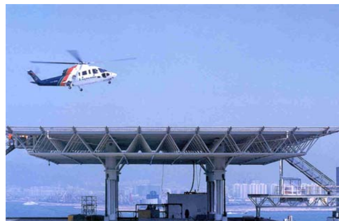
港澳碼頭直升機場
