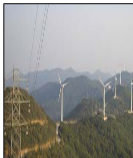
廣東南澳(2007) 45兆瓦風力發電
