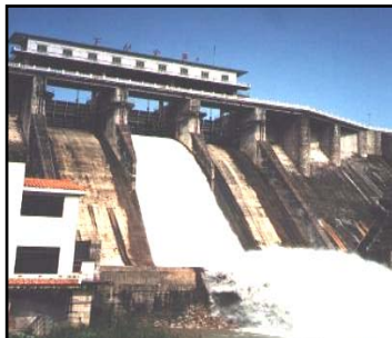
廣東懷集 98兆瓦 水力發電 (82兆瓦 已投產)
