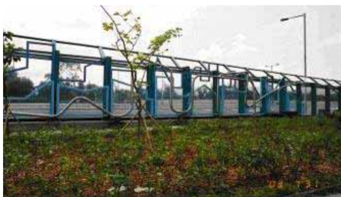
在東區走廊設置的隔音屏障。
