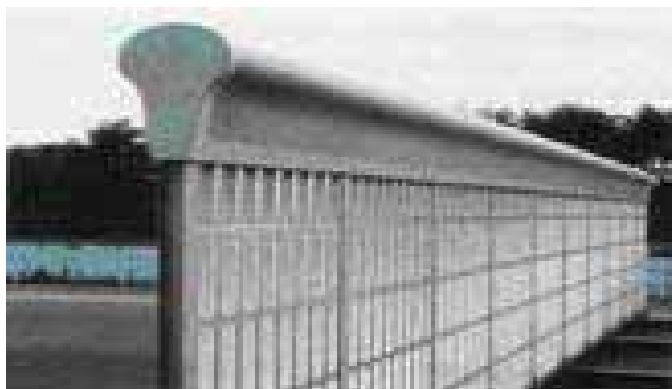
沿隔音屏障頂部附設的吸音裝置。
