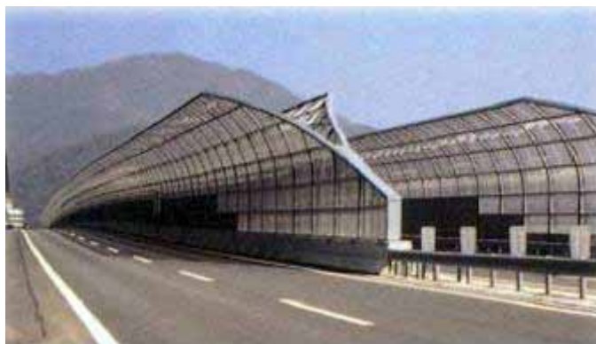
使用鋁架及聚碳酸酯板的輕型隔音屏障實例。
