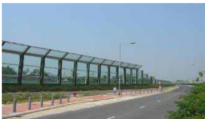
元朗高埔村外沿錦田公路設置的懸臂式隔音屏障。
