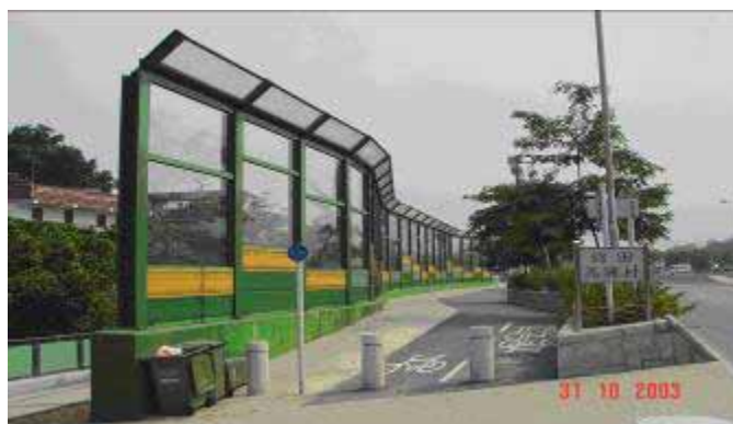
位於錦田公路近青朗公路路口的隔音屏障，是採用較輕物料而外觀設計與附近環境融為一體的實例。
