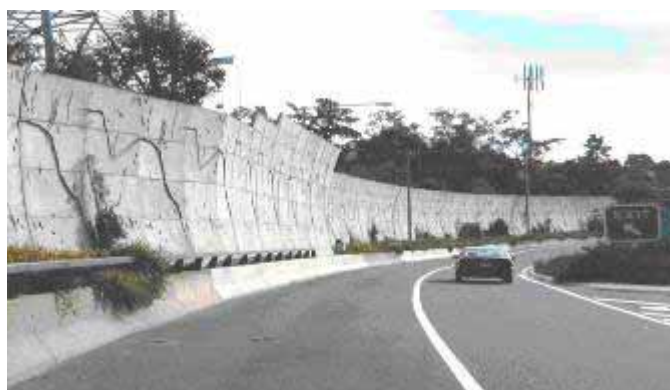
注重景觀的路段採用輕質混凝土屏障。
