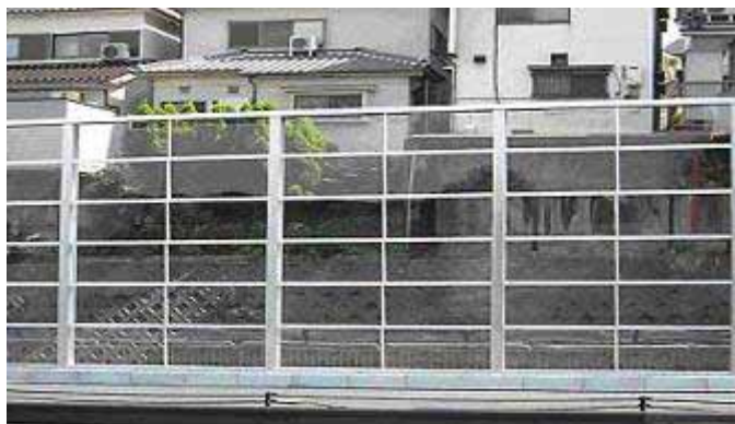
日本常見的透明隔音屏障。
