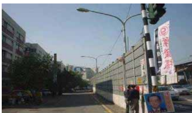
台灣設置的隔音屏障。
