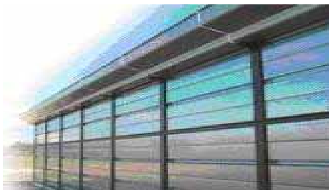
可有效衍射及吸收聲音的隔音屏障實例。
