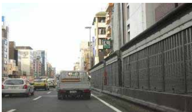
沿繁忙道路設置的隔音屏障。
