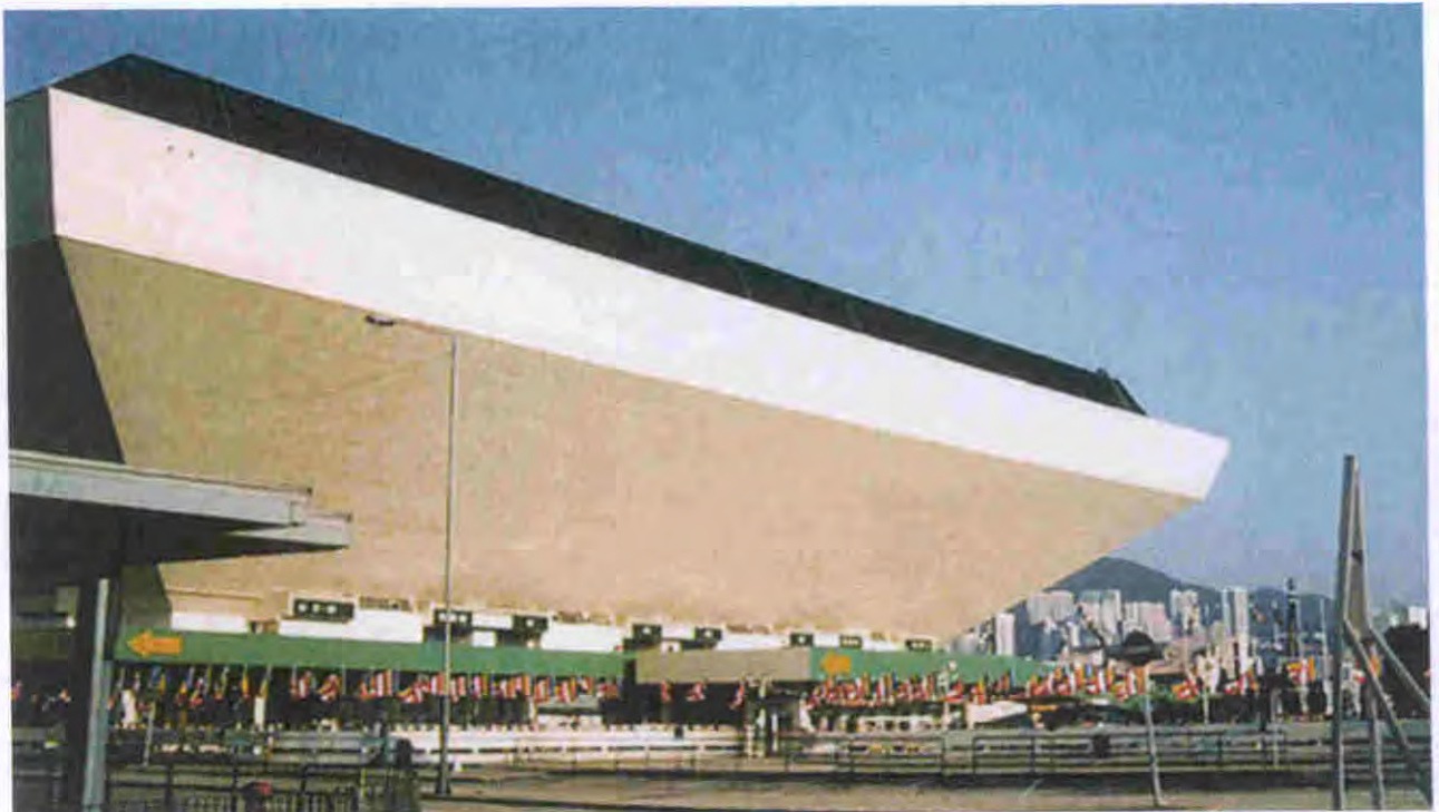
Improvement to Hong Kong Coliseum (Before) 香港體育館改善工程 (工程前)
