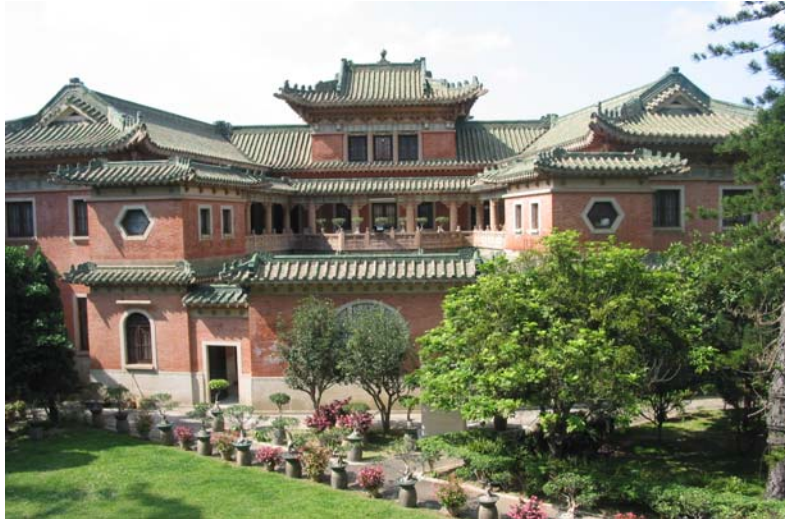
The Building at 45 Stubbs Road 位於司徒拔道 45 號的建築物
