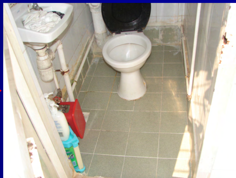
鋪防水層及地磚後
