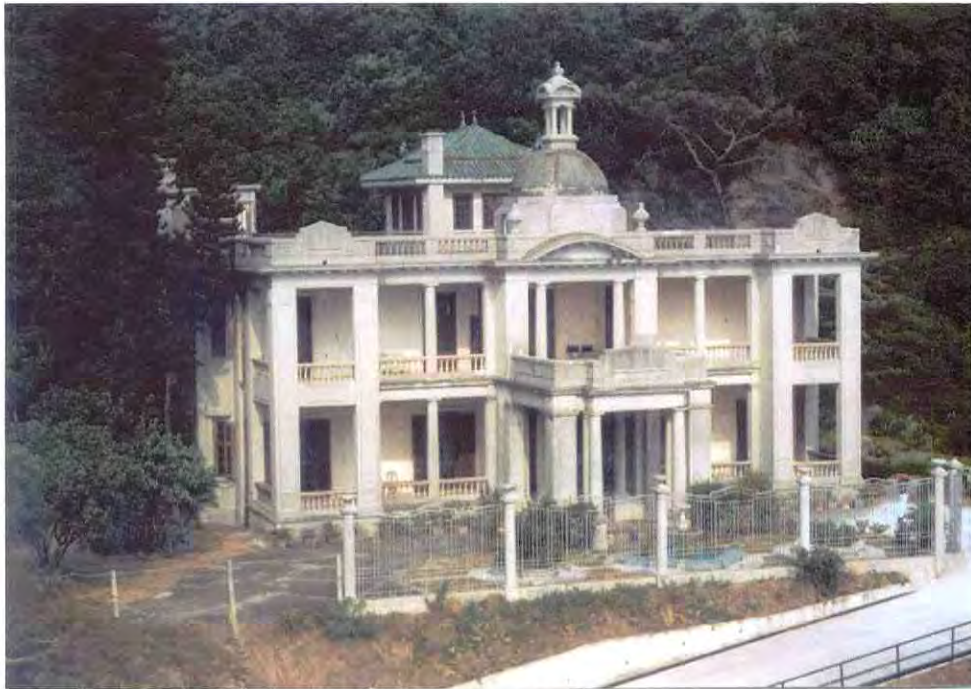
Façade of the Building 建築物的正面
