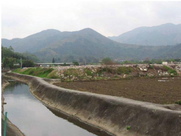
填土臨近排洪河道，鬆散的泥土有機會淤塞渠道，雨季來臨，出現水浸時才處理，可能已為時已晚。
