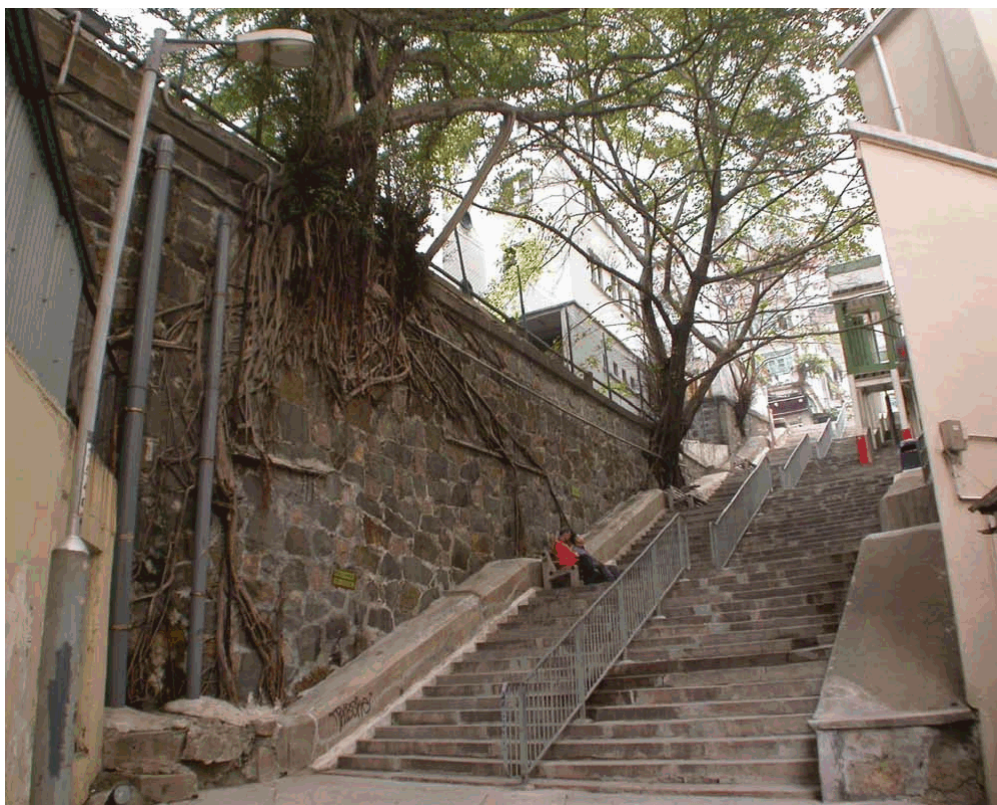
相片(3)：沿城隍街以粗石砌成的擋土牆和樹
