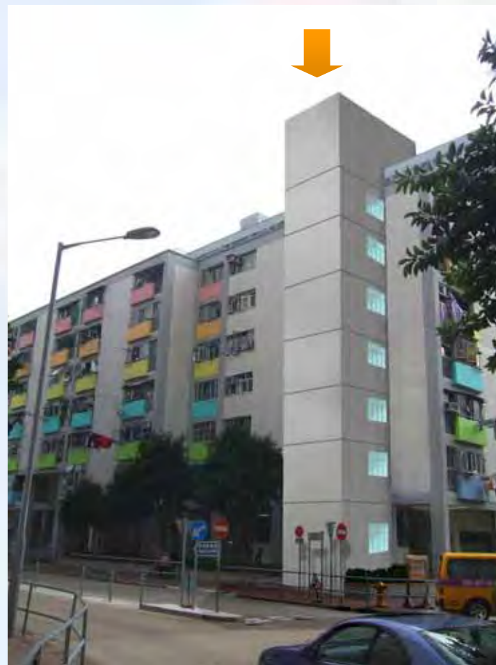
升降機樓加裝後
