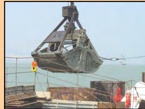
密閉抓鬥式挖泥可減少工程區沈澱物的濃度
