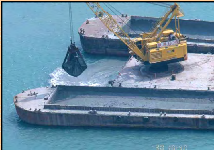
密閉抓鬥式挖泥可減少工程區沈澱物的濃度
