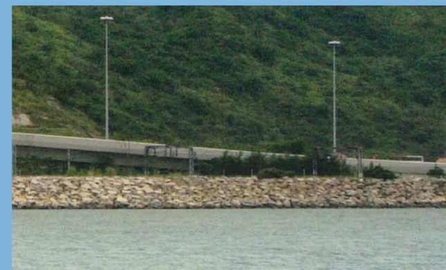
Existing View 現有景觀
