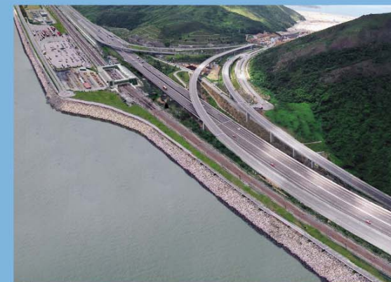
Existing View 現有景觀
