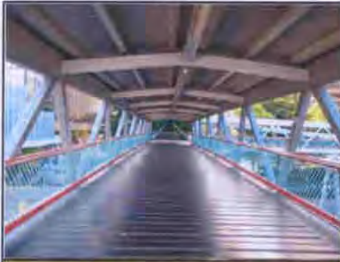
現有行人天橋的橋面 EXISTING FOOTBRIDGE DECK
