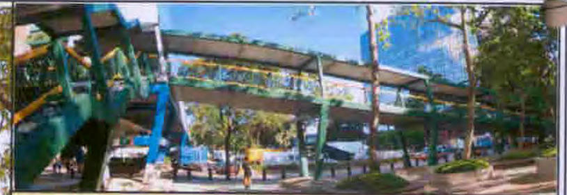
現有行人天橋 EXISTING FOOTBRIDGE
