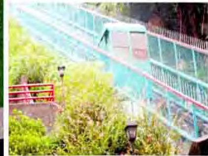
Inclined lift / 斜道升降機
