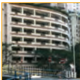
樓宇下的多層停車場
