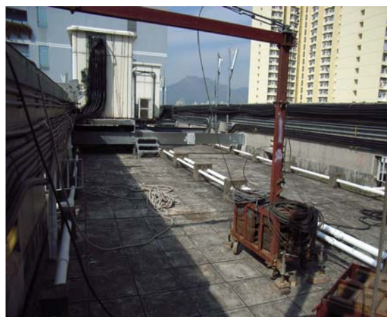
早期平衡墜重車台設計，以安裝吊船工作台和救生索
