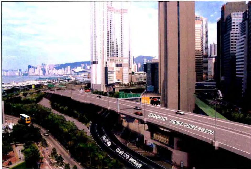
視圖 1 - 林士街天橋 VIEW 1 - RUMSEY STREET FLYOVER
