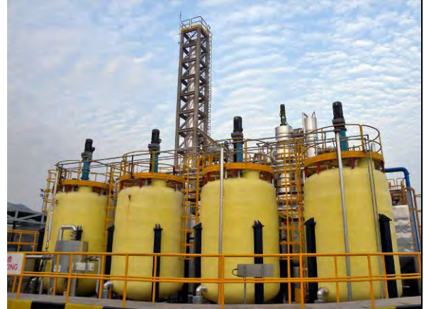
2010年5月初 進展: 處理設施已經完成，並已開始運作
