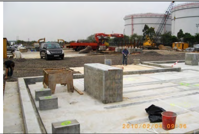
2010年2月 進展: 剛完成大型剪鐵機的基座
