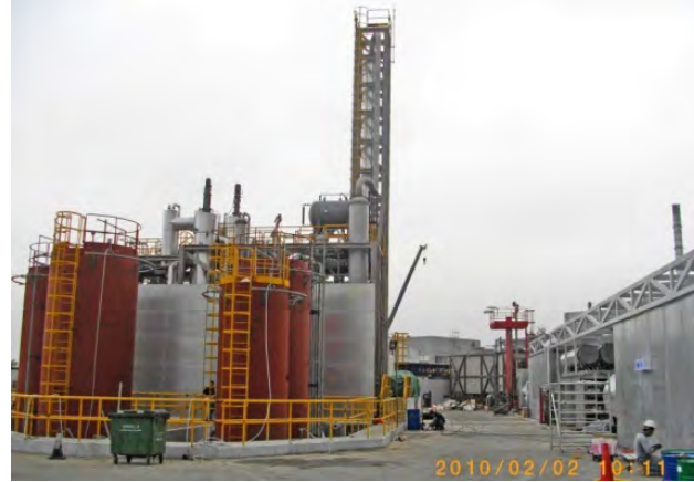
2010年2月 進展: 處理設施大致完成
