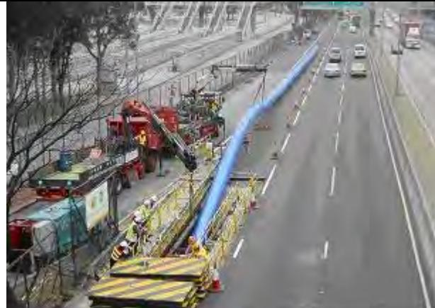
這是在大埔公路沙田段以鍛模套管技術進行水管修復工程的實例。方法是首先將全新的聚乙烯喉管在現場拉過特製的模具而使喉管直徑臨時縮小，然後將聚乙烯喉管拉入需要修復的水管內。當完成水/蒸氣護養後，聚乙烯喉管會回復至原來的大小。
