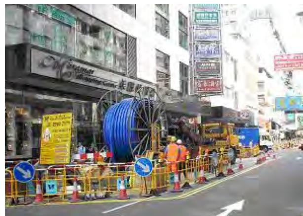
這是在金巴利道以內喉緊貼技術進行水管修復工程的實例。方法是將預製 U 形聚乙烯喉管拉入需要修復的水管內。當完成加壓蒸氣護養後，聚乙烯喉管會回復至原來的圓形狀態。
