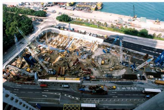
地基工程 Foundation Work
