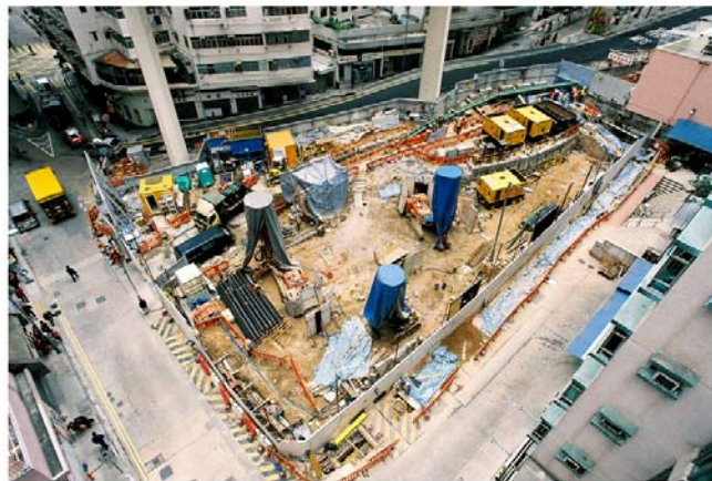
豎井建造工程
