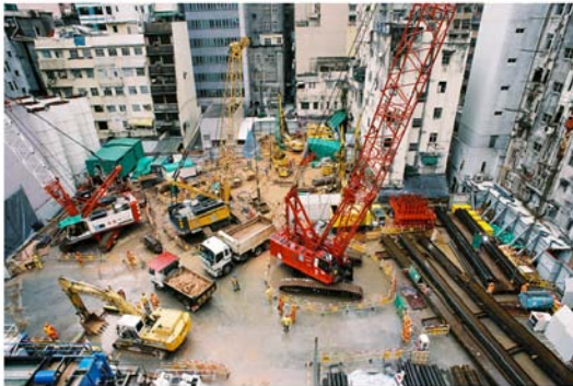
豎井建造工程
