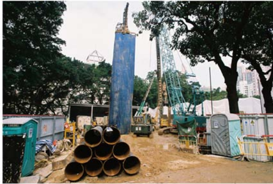
豎井建造工程 Shaft Construction Work
