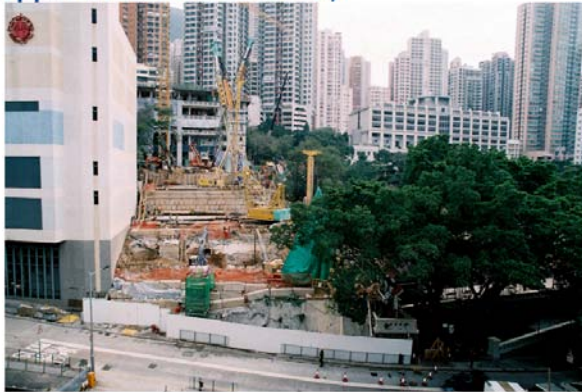
地基工程 Foundation work
