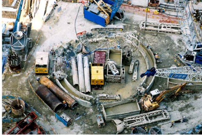
豎井建造工程 Shaft Construction Work
