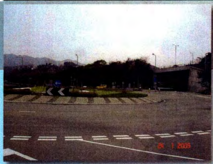
現有的景觀 EXISTING VIEW
