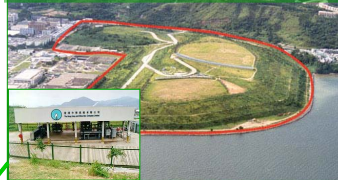
Shuen Wan Landfill (1999)
