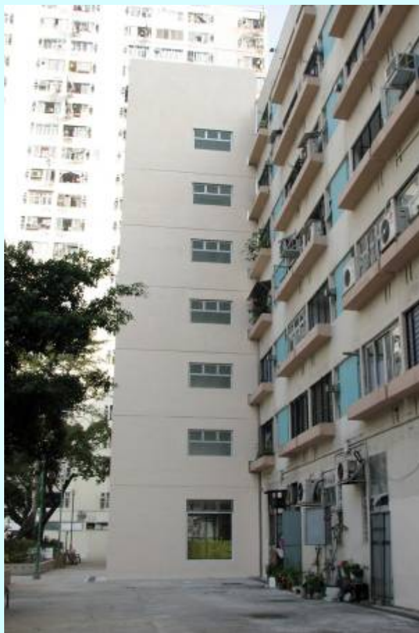
完成加設升降機 - 梨木樹(二)邨(第四座)
