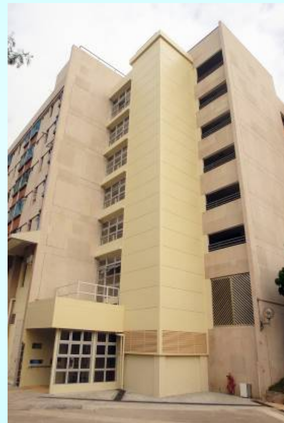
完成加設升降機
