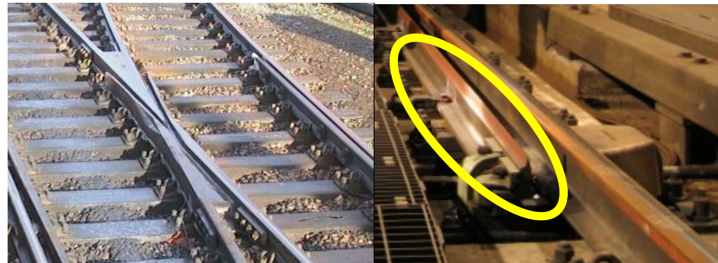
道岔內的路軌接位及轉綫尖軌
