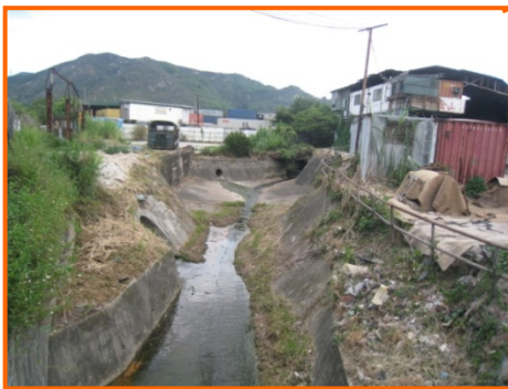
位於朗漢路旁的排洪渠
