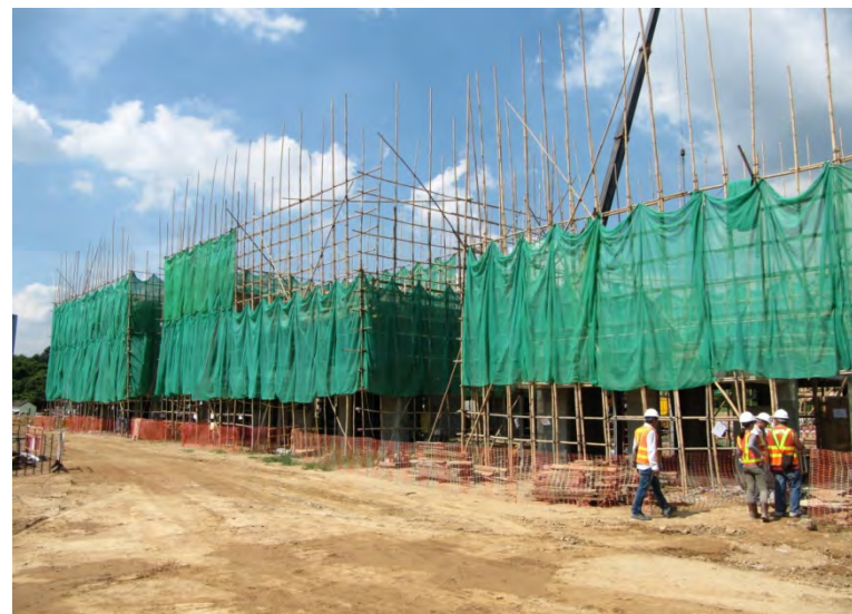
重置屋宇正在施工。
