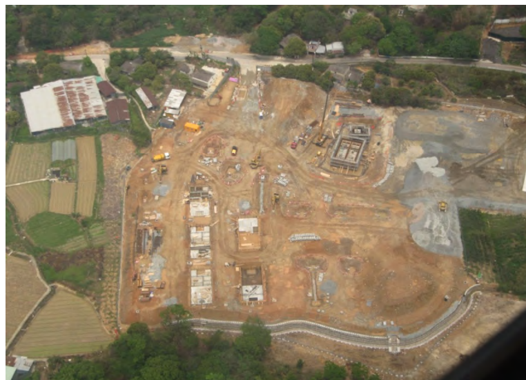
重置竹園村的工程正在進行中。
