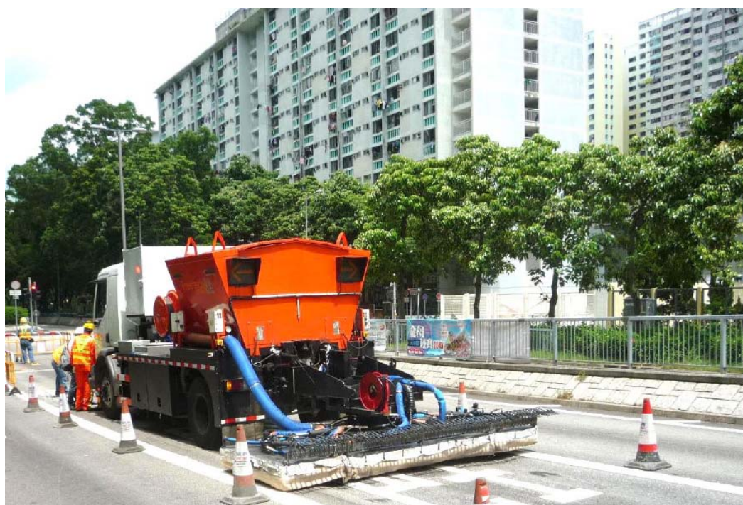
〔附圖四〕 大型熱能修路機正在進行路面重鋪工作
