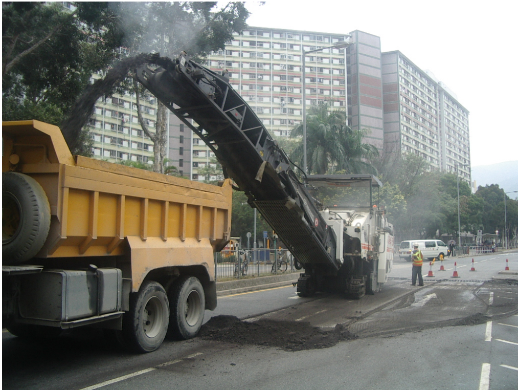
〔附圖一〕 傳統瀝青路面維修方法- 刨掘機將已損壞的物料打碎移走
