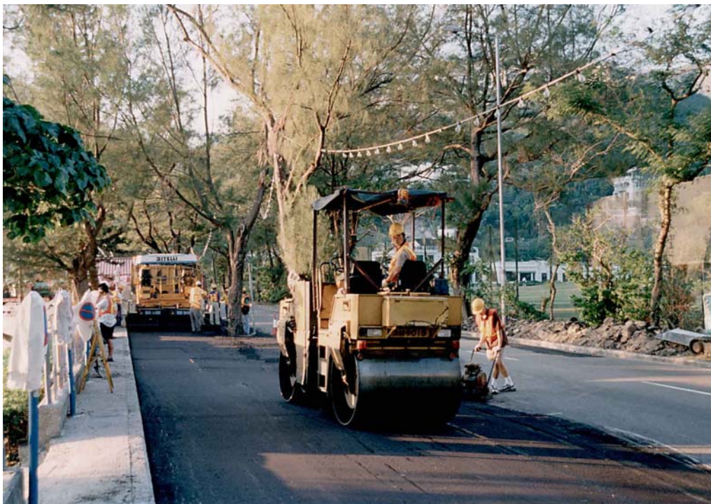
〔附圖二〕 傳統瀝青路面維修方法- 鋪上新瀝青物料及壓實
