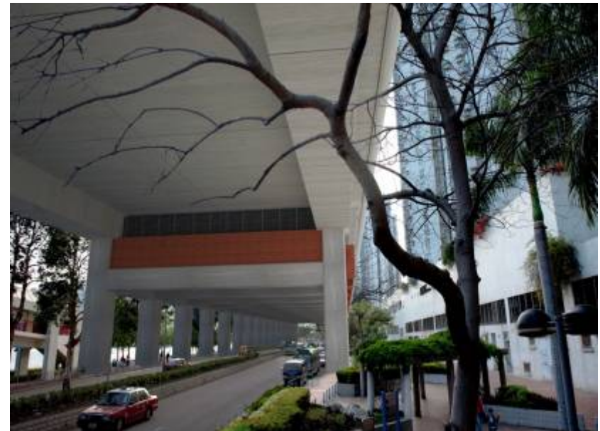
屯荃鐵路車站的合成照片（灣景） Photomontage of the TMTWL Railway Station (Bayview)
