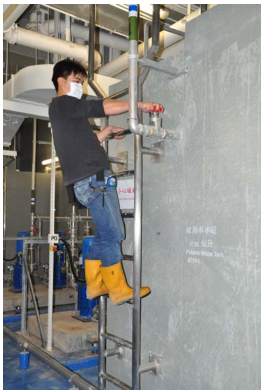
工人關閉立法會綜合大樓供水系統，以便進行供水消毒工作。
