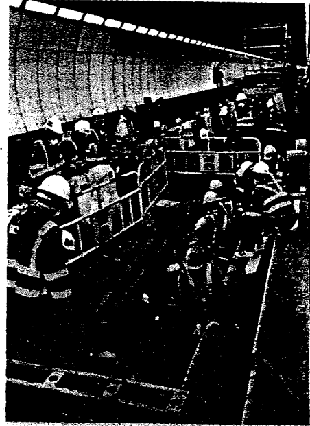
運輸署於火警後連日在隧道內進行復修工程。 政府新聞處
