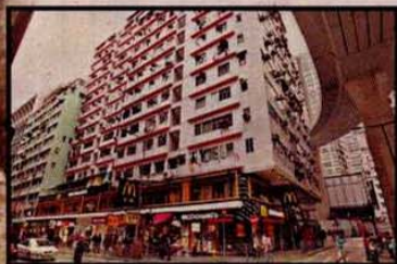
■新安大廈在港鐵爆破工程展開後，發現逾 20 處裂痕。何柏佳攝
