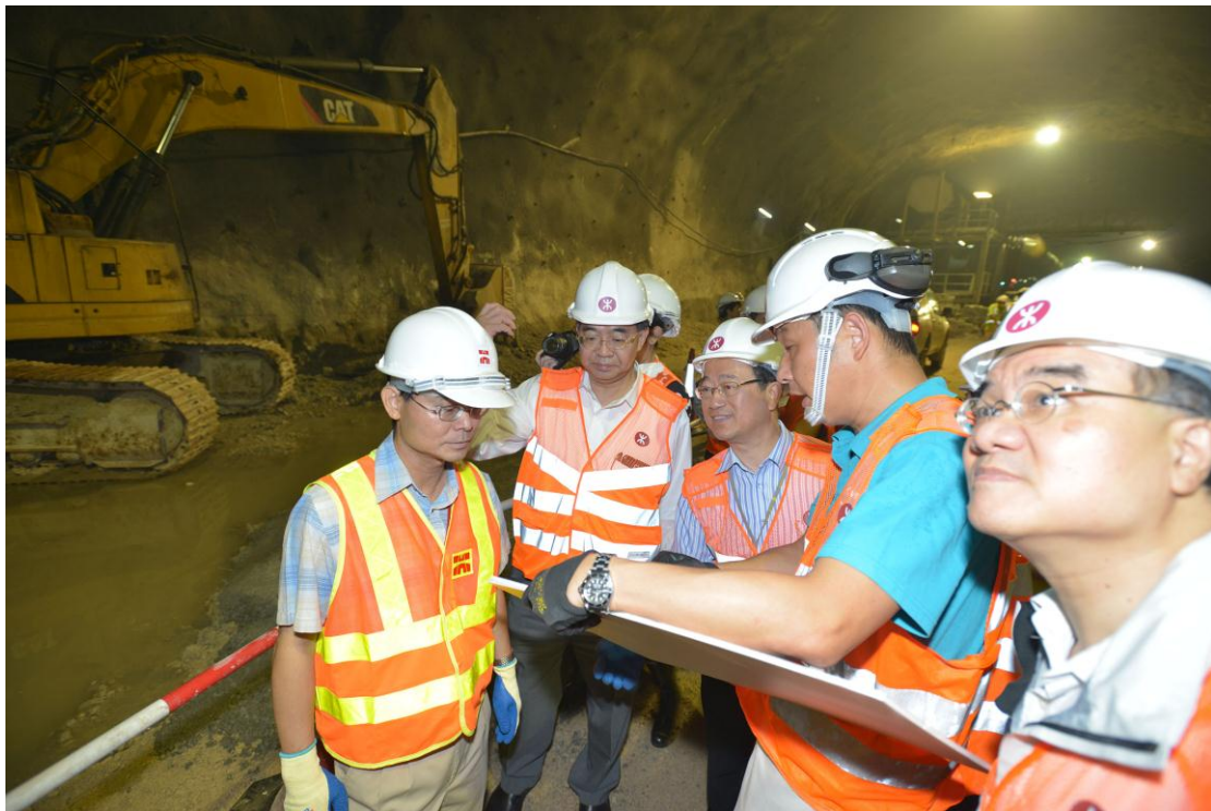
立法會議員視察高鐵地底主要隧道的建築工地，並聽取港鐵代表講解建造工程。
