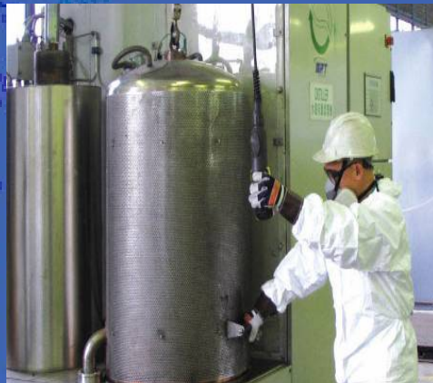
蒸餾處理設備
