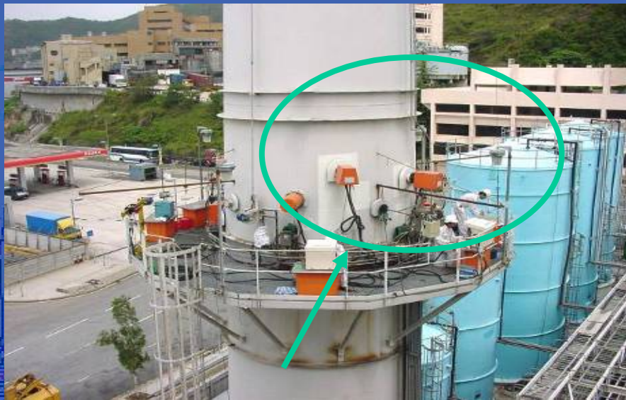
每月於煙囪現場取樣
