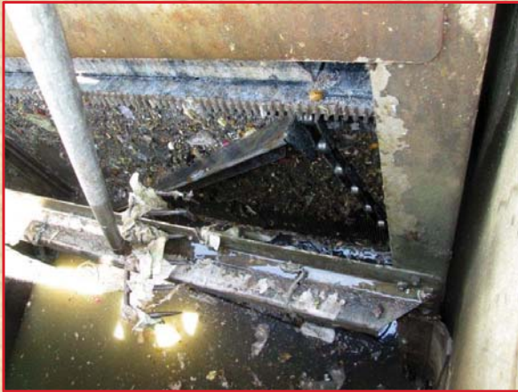
被幼隔篩隔出的雜物， 不能被耙走，造成堵塞
