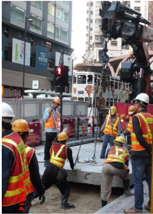
附圖五: 於工地現場放置預製混凝土板塊
