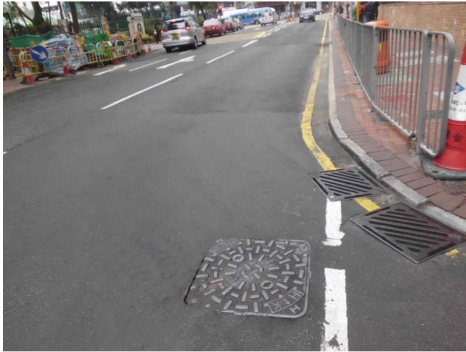
附圖三: 使用熱能修路機重鋪的路面照片
