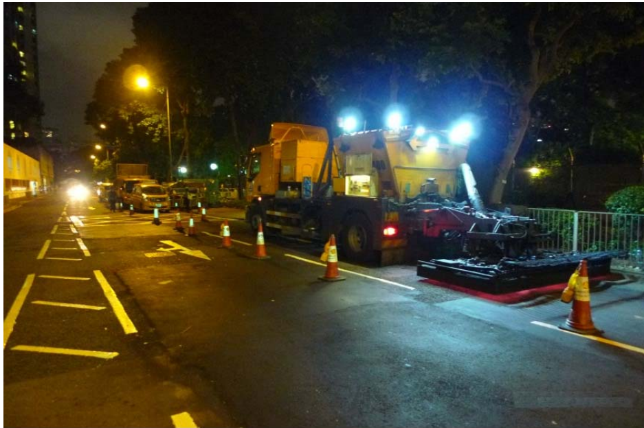
附圖二 : 使用熱能修路機進行路面重鋪工程
