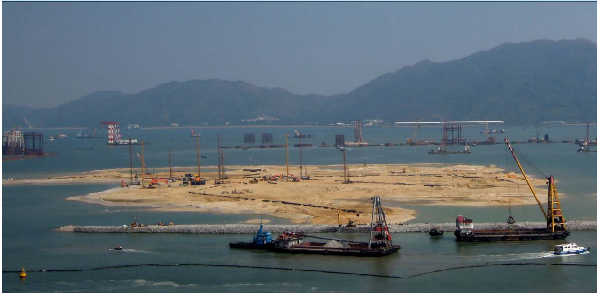
香港口岸(旅檢大樓)堆砂填海現況
