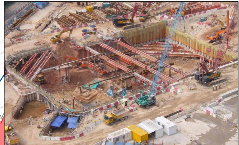
豎井大型挖掘及支撐結構安裝工程已暫停
