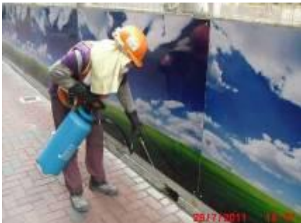
加強整理工地環境 Site housekeeping
