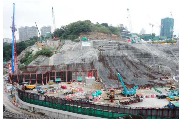
明山爆破大型爆破保護網 Roof over for open blast
