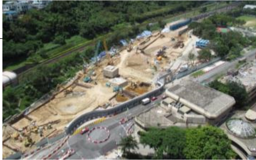
顯徑站 地基工程經已完成，進度良好
