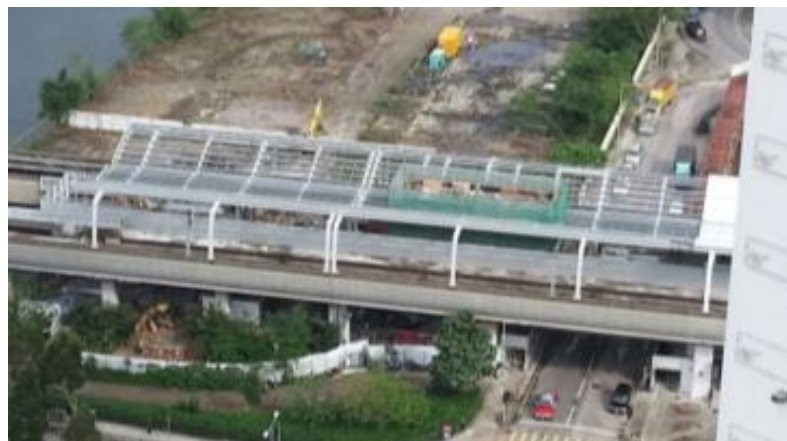
馬鞍山綫車站月台改建工程 Platform Modification Works at Ma On Shan Line
