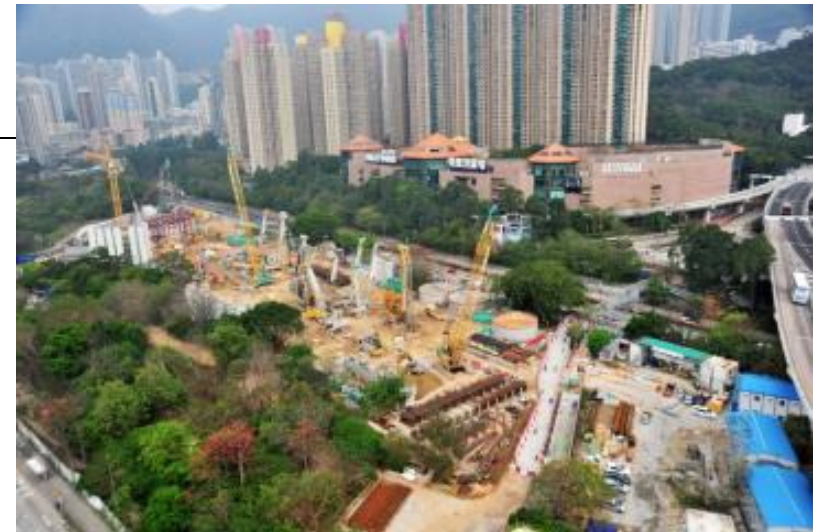
鑽石山站 調整施工工序及方法以追回受地質狀況影響的隔牆工程進度
