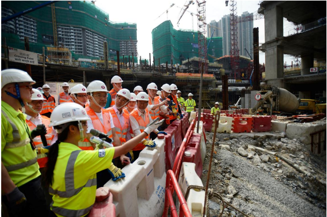
議員視察高鐵香港段西九龍總站的建築工地。
