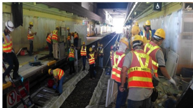
東鐵綫車站月台改建工程
