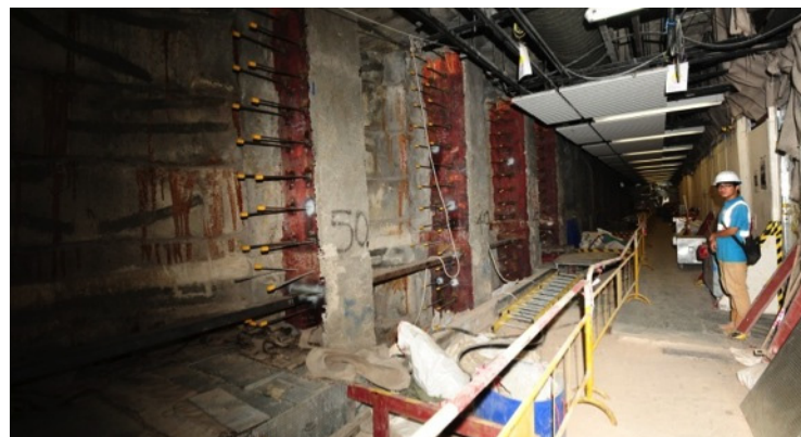
鑽石山站內進行改建工程
