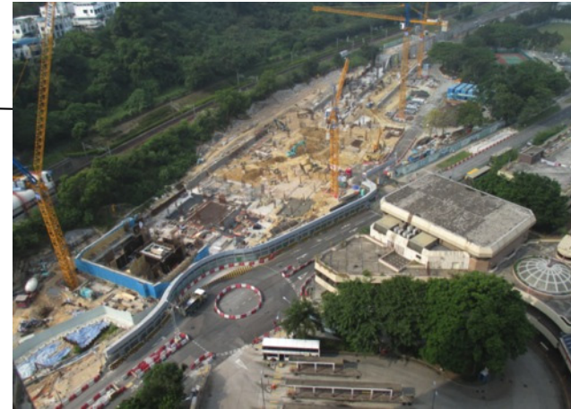
顯徑站 正進行車站主體結構工程
