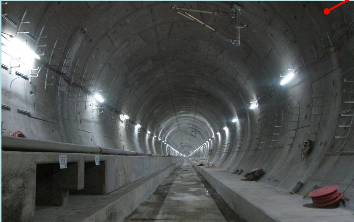
米埔至牛潭尾段南行綫隧道已完成內部結構， 並準備鋪設路軌
