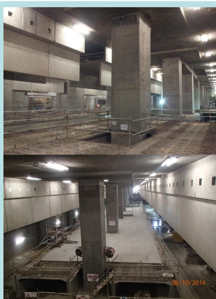
B4層正進行架空通風管道及月台預製件安裝工程
