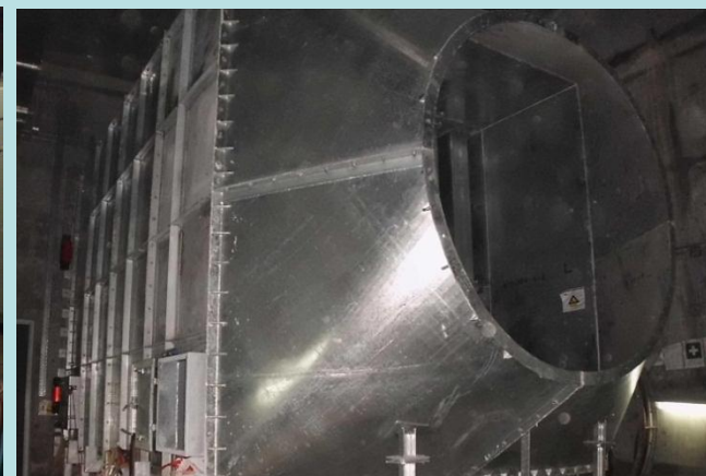
通風系統正於 通風大樓進行安裝
