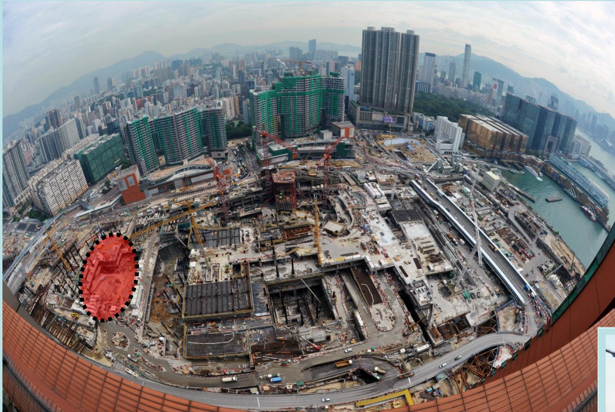
採用爆破方式移除總站北面地底岩石
