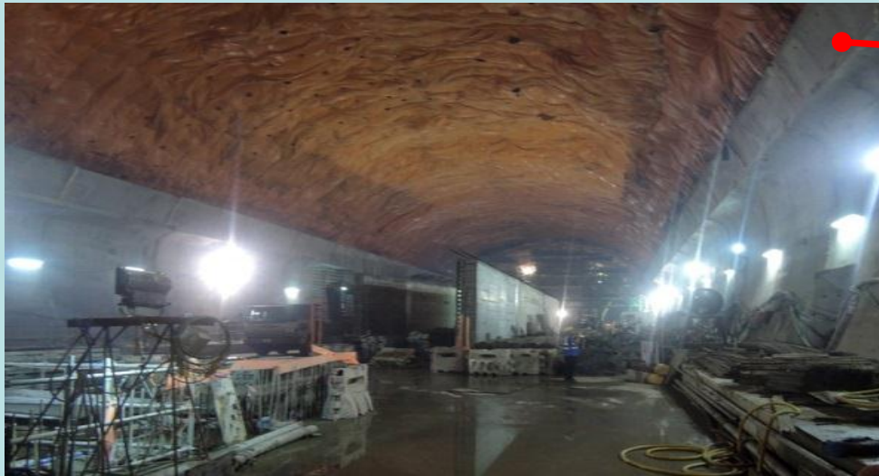
牛潭尾隧道工地
