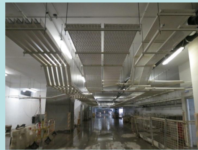
B2層部分停車場位置已經完成 初期裝修及機電安裝
