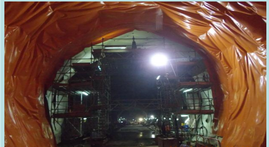
大江埔隧道工地
