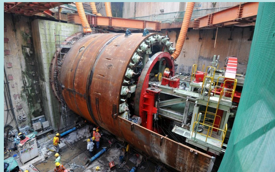
重新組裝鑽挖機
