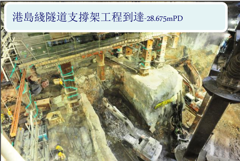
車站隧道結構工程現正進行
