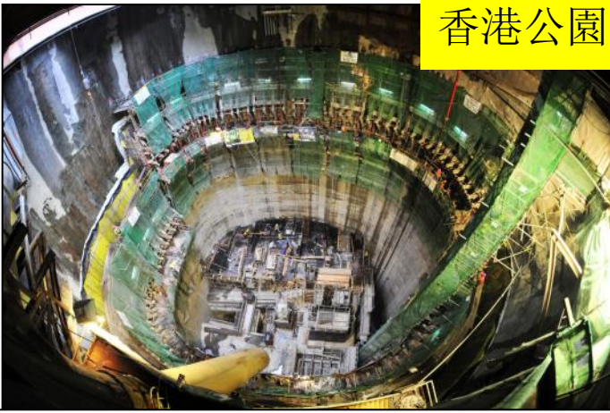
通風大樓結構工程現正進行
