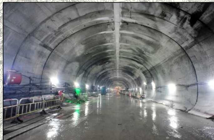
隧道壁結構工程現正進行
