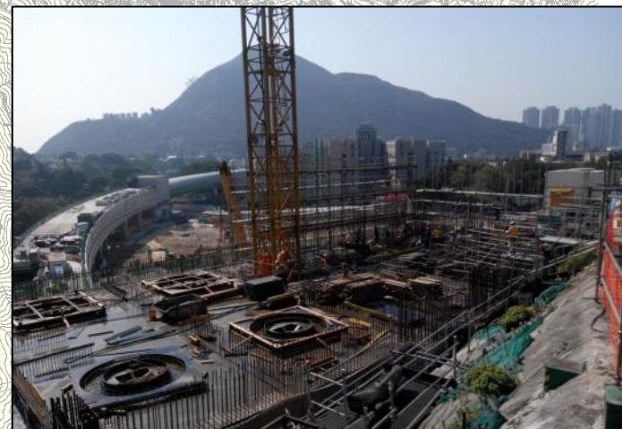
通風大樓結構工程現正進行
