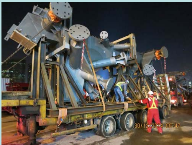
支撐總站柱頂鋼結構組件
