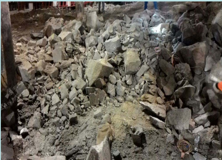
採用爆破方式移除總站北面的地底岩石
