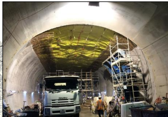
隧道壁結構工程大致完成
