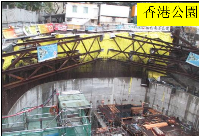
通風大樓結構工程現正進行
