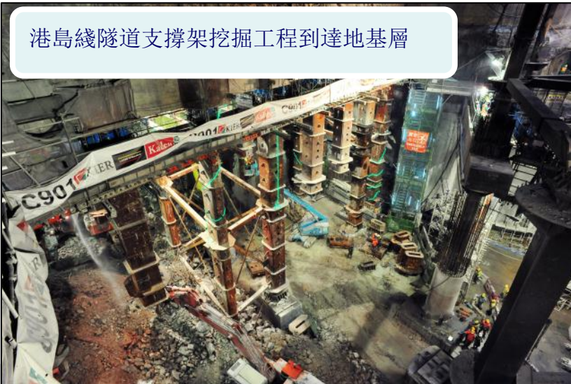
洞穴結構工程現正進行
