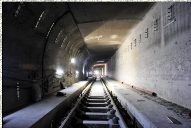
軌道鋪設工程現正進行
