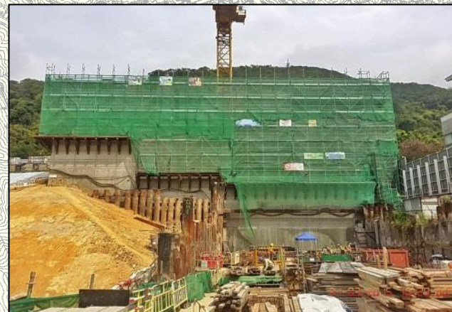
通風大樓結構工程現正進行
