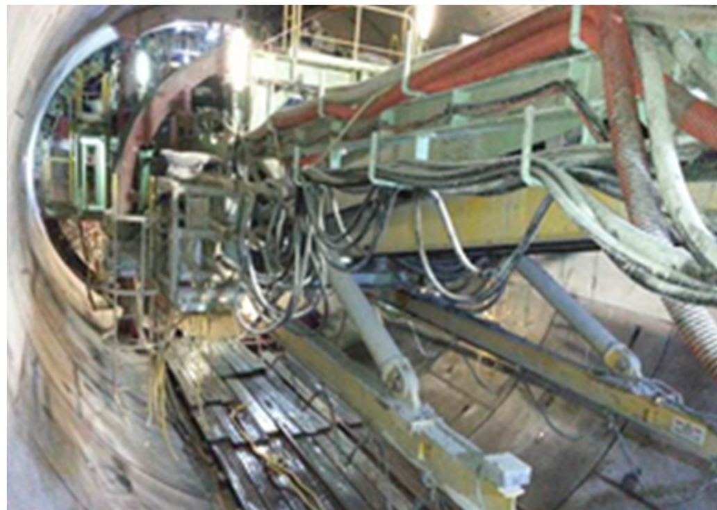
南段隧道鑽挖機正在鑽挖北行綫
