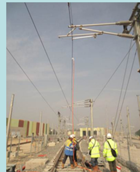
架空電纜系統測試
