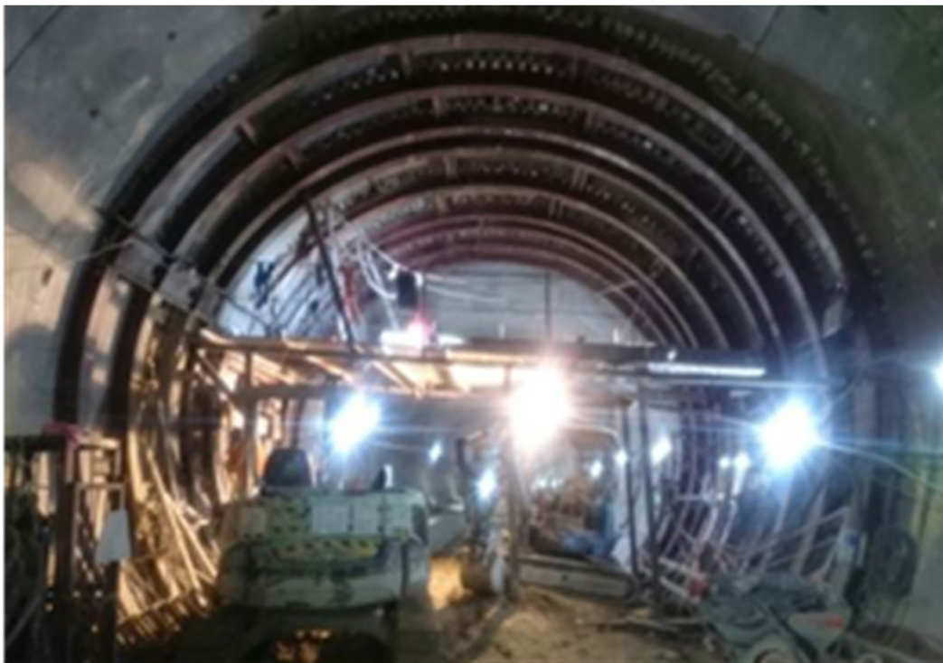
石崗北段正建造連接隧道
