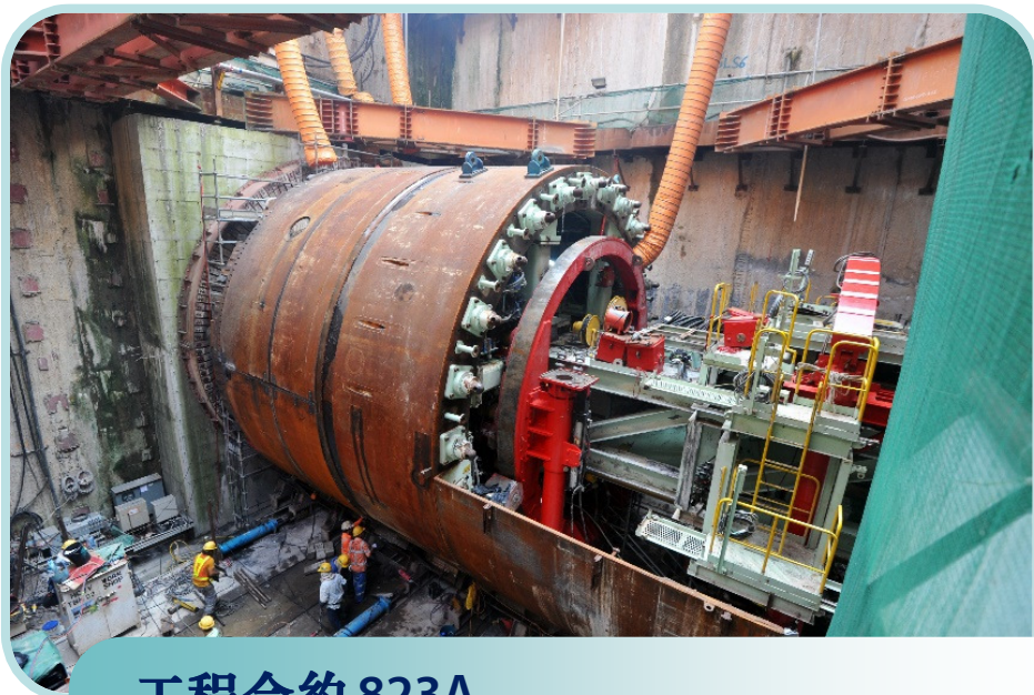
工程合約 823A 大江埔至謝屋村段隧道鑽挖機重新啟動
