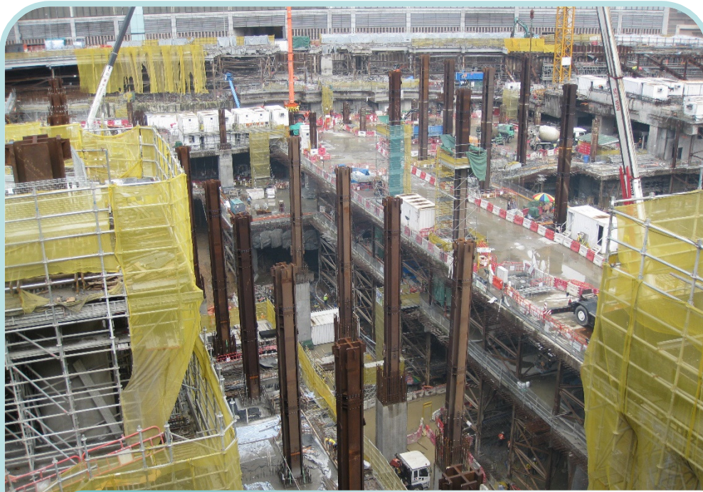
西九龍總站地庫 B3 層 橫向永久支撐工程已完成
