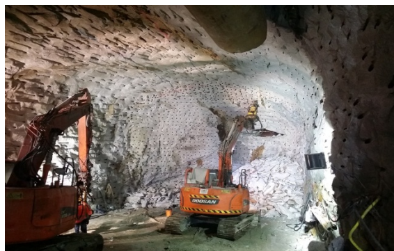
黃埔站月台隧道挖掘工程
