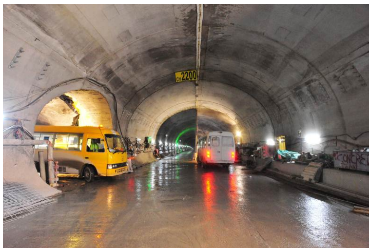
南風隧道的隧道壁工程已大致完成
