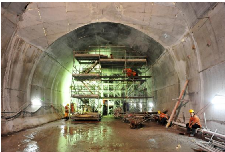
利東站利東邨出入口結構工程
