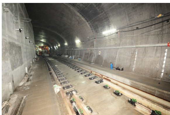
油麻地至黃埔之間的列車隧道結構工程
