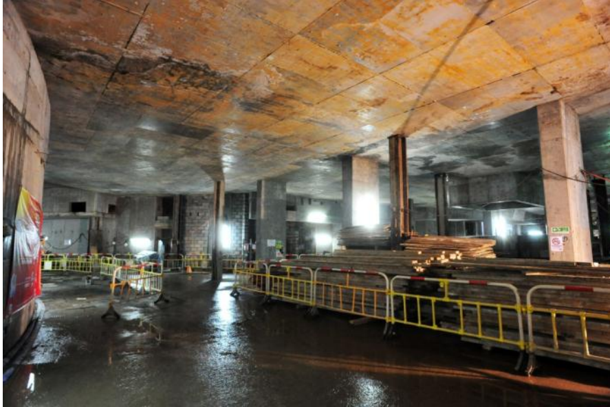
海怡半島馬路鋼板下的車站結構工程
